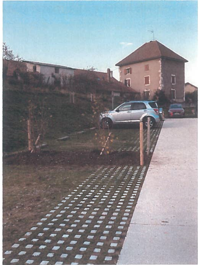
Exemples de projet réalisés avec des stationnements mis en œuvre par des pavés enherbés.
