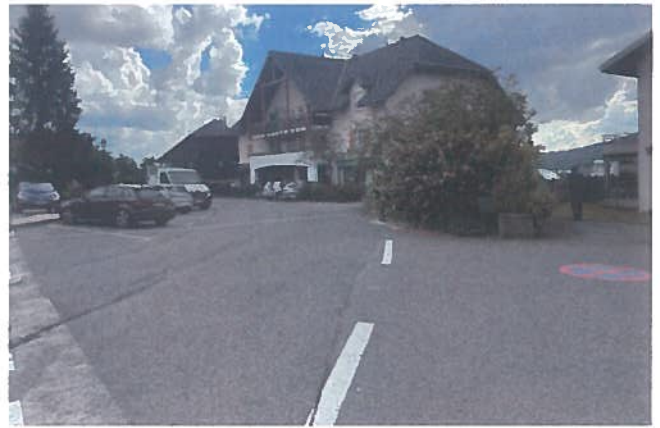
Voiries, trottoirs, stationnements non lisibles
