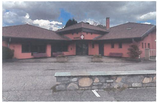
Parvis et accessibilité non mis en valeur
